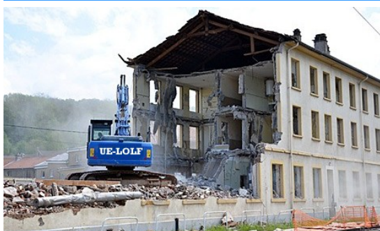
Bâtiment de la Douane à Apach en Moselle
